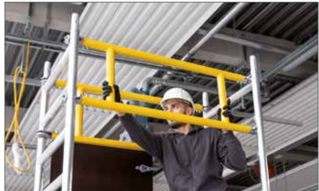
Montage im absturzgesicherten Bereich dank 3-T-Methode
