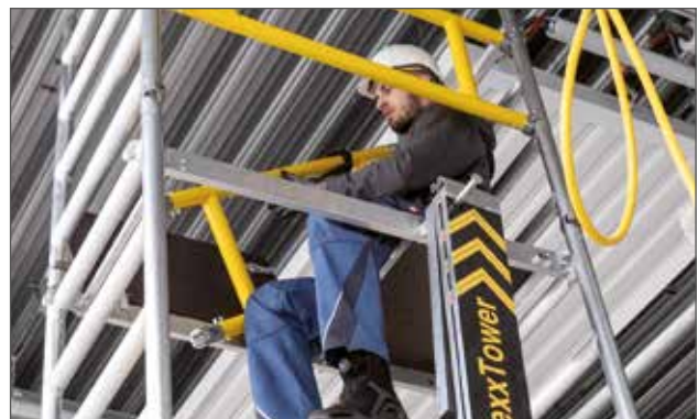
Obere Geländer und Bordbretter montieren
